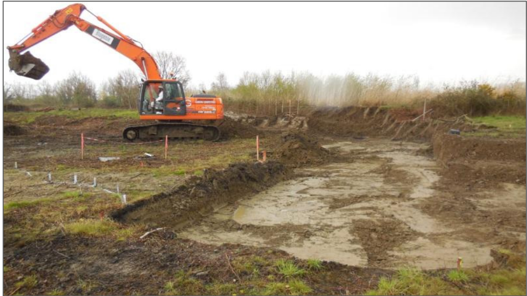
Photographie 11-1: Parcelle 14 : excavation du nord du spot (vue de l'est)
