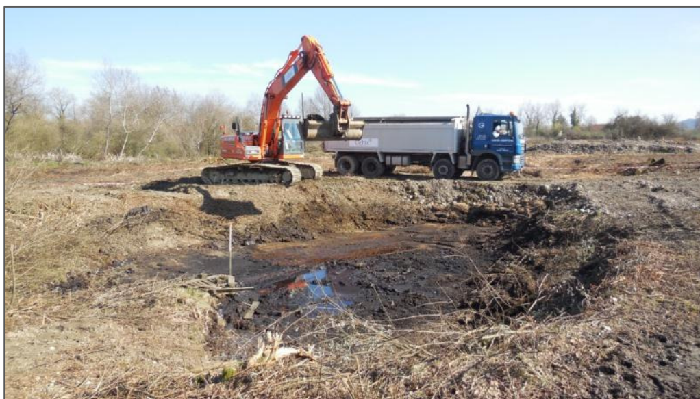
Photographie 13-3 : Parcelle 20 : Excavation de la fosse à polymère
