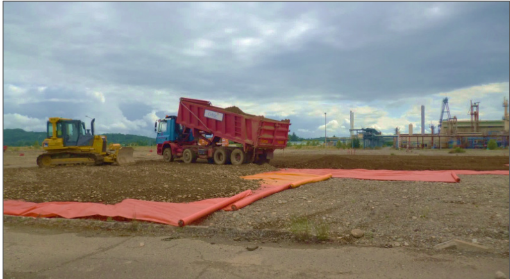
Photographie 5-4: Parcelle 8-est : pose du géotextile avertisseur et de la couche de matériaux propres
