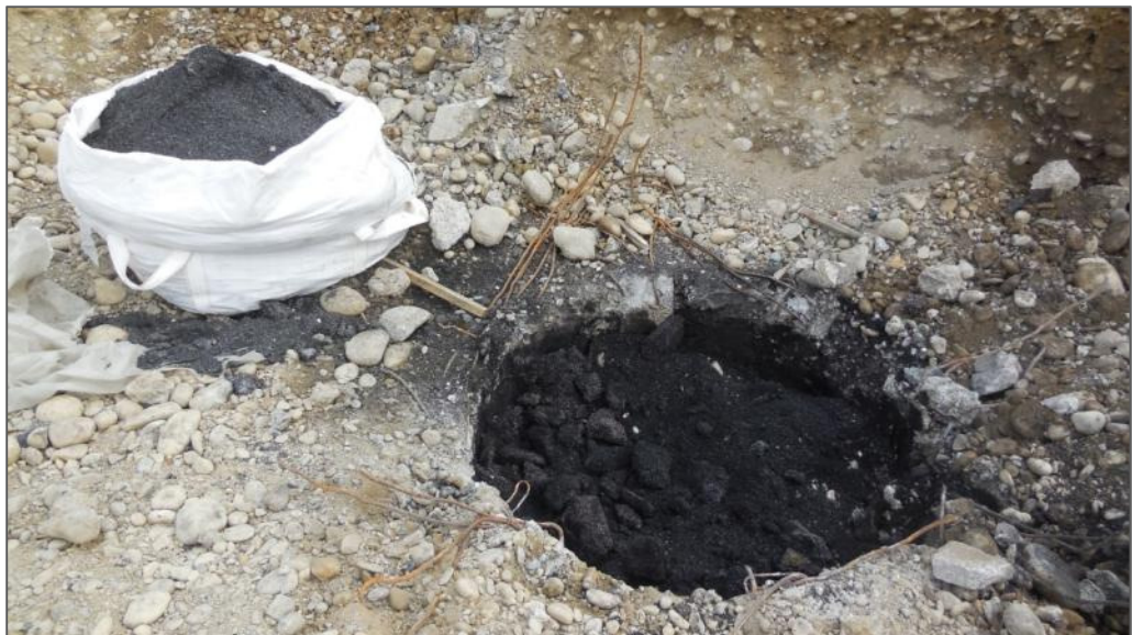
Photographie 12-3 : Parcelle 18 : fosses de catalyseur en cours d'évidement
