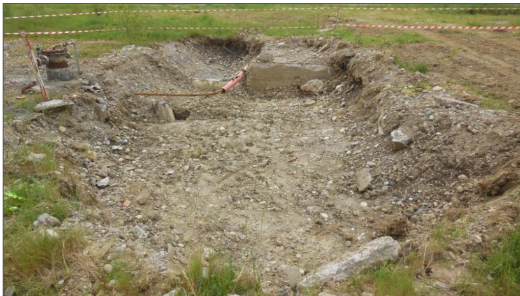
Photographie 4-1 : Parcelle 7 : partie nord de la zone d'excavation – en haut au centre, structure béton ayant limité l'excavation
