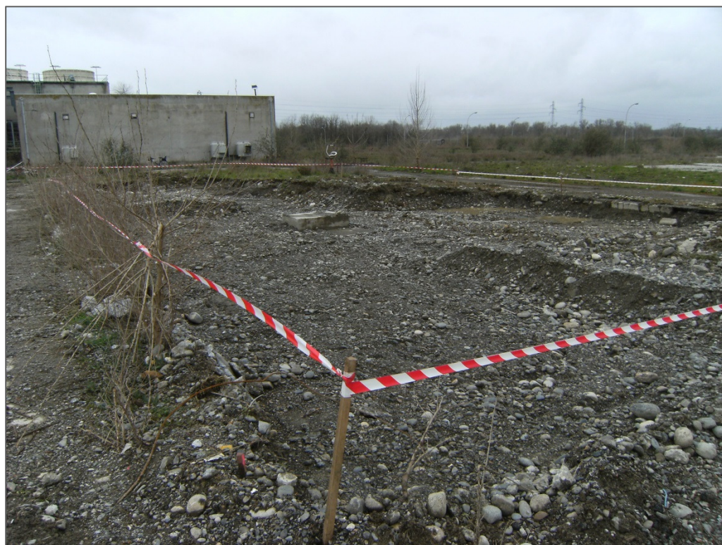
Photographie 5-2: Parcelle 8 : partie sud de la zone d'excavation (vue du sud-est)
