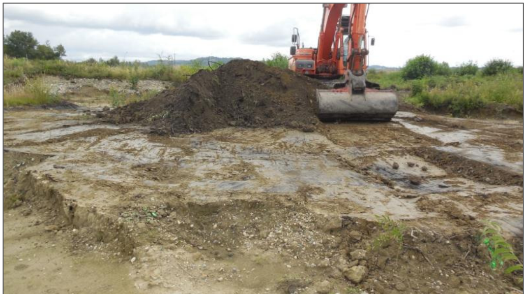
Photographie 11-2 : Parcelle 14 : raclage de l'horizon superficiel composé de noir de carbone
