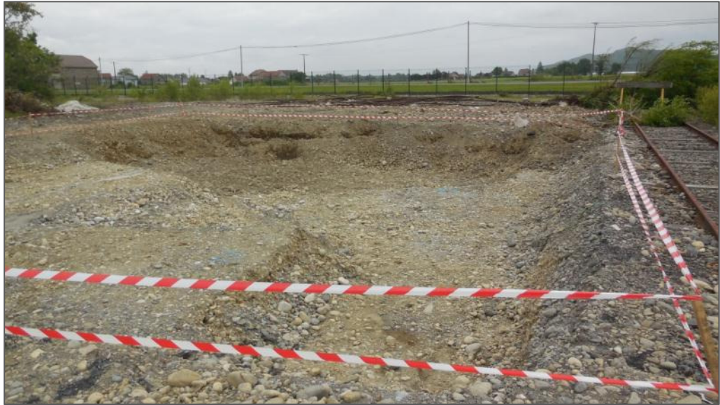
Photographie 12-2 : Parcelle 18 : zone de pollution entièrement excavée (vue du sud-ouest)
