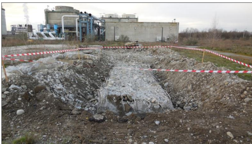
Photographie 5-1: Parcelle 8 : destruction des structures bétons au BRH
