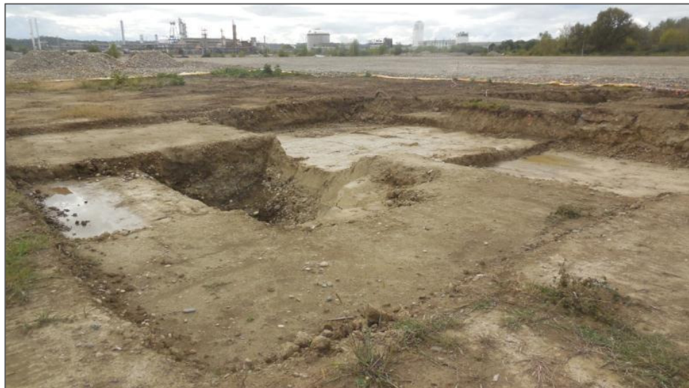
Photographie 11-3 : Parcelle 14 : zone d'excavation principale du spot nord-est
