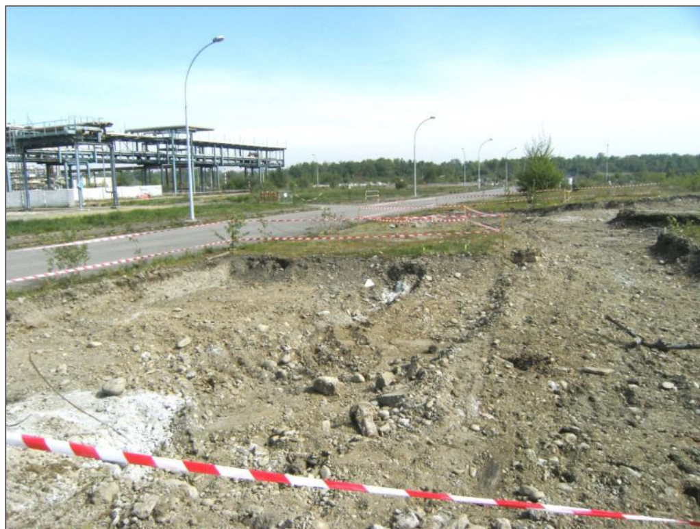
Photographie 8-1: Parcelle 12 : fouille après la première phase d'excavation de la zone de pollution (vue du sud)
