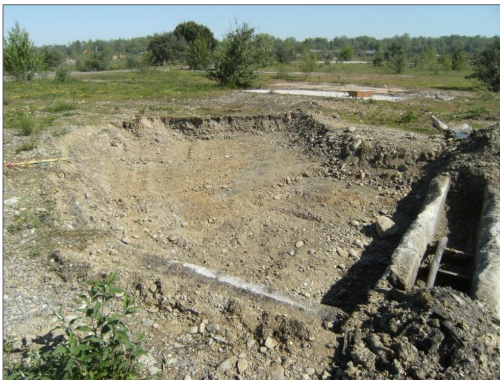
Photographie 9-1 : Parcelle 13-AVM sud : zone d'excavation vue du sud - à droite, caniveau traversant le spot
