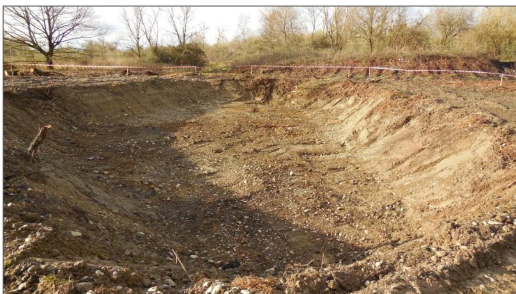
Photographie 13-4 : Parcelle 20 : Fosse à polymère entièrement excavée
