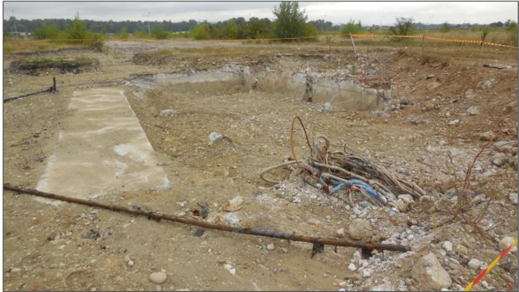
Photographie 8-2 : Parcelle 12 : fouille après la deuxième phase d'excavation
